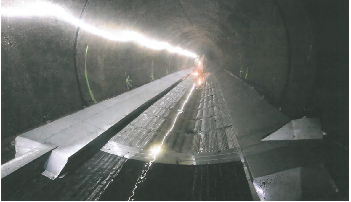
Einblick in die im Kanal verbaute Technik, © Andreas Steindl
